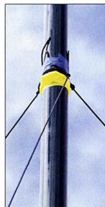
Bild 41: Befestigung der Abspannleinen
