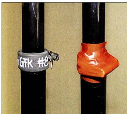
Bild 39: Montierte Schelle (links), mit Klebeband umwickelt (rechts)
